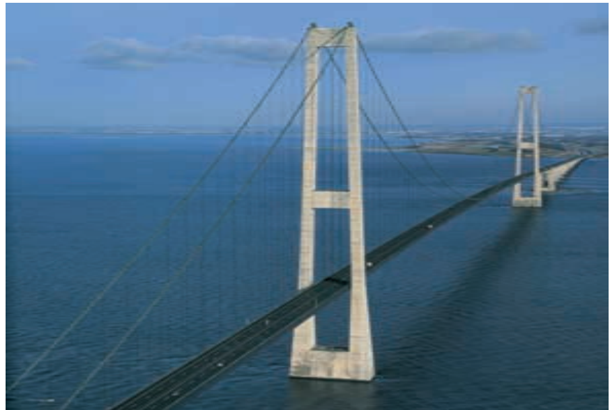
Brücke über den großen Belt, Dänemark, 2000
