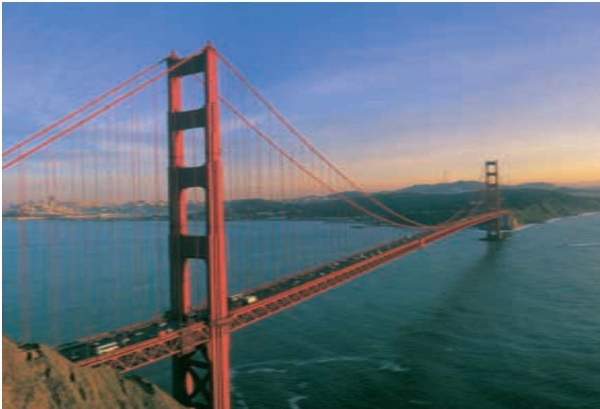
„Golden Gate Bridge“, San Francisco, 1937
